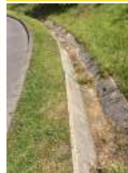
« Toujours favoriser l'infiltration des eaux superficielles pour ne pas en reporter la gestion en aval : une noue ou un fossé de 0,5 m<sup>2</sup> peut absorber l'eau d'une surface de 15 m<sup>2</sup>. Cela permet également d'éviter les pollutions dues aux eaux de ruissellement routier. »
